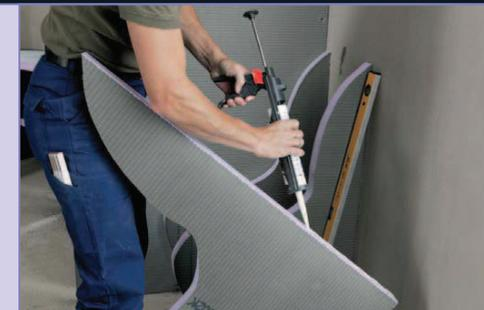
Les panneaux JACKOBOARD seront collés avec la colle de montage JACKODUR sur le mur et au sol à des distances de 40 cm.
