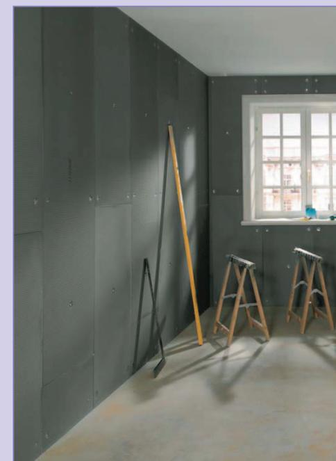
Les panneaux fixés, il ne reste que les joints à étancher avec la bande d'étanchéité JACKOBOARD. Les panneaux peuvent être directement carrelés.
