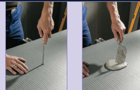
Lors de la mise en oeuvre des panneaux à carreler JACKOBOARD sur les murs, faire 8 trous avec un tournevis (5 par m2) comme marquage pour l'envers. Après ce marquage, recouvrir les trous du mortier.
