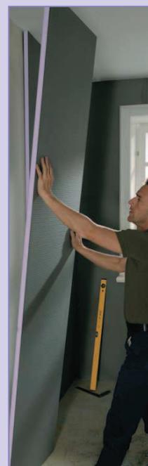
Le panneau est posé au sol de façon inclinée et appliqué au mur en respectant le niveau.
