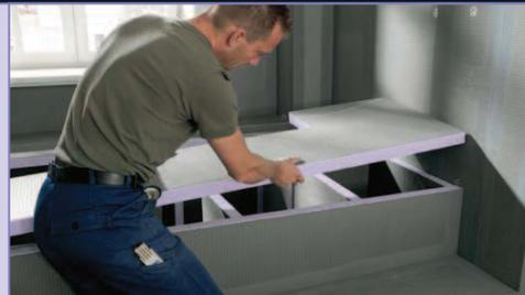
Un panneau JACKOBOARD est découpé et vient en recouvrement du support de construction. Celui-ci est collé avec la colle de montage JACKODUR.
