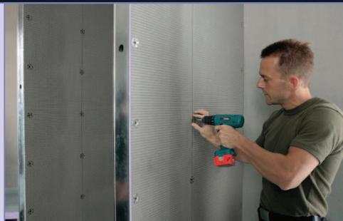
Les panneaux JACKOBOARD sont fixés avec des vis (5 par m<sup>2</sup>) en utilisant les rondelles de fixations acier.
