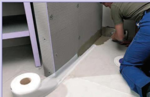
Afin de réaliser une parfaite étanchéité du support entre les panneaux muraux, le bac de douche JACKOBOARD et la chape, utiliser la bande d'étanchéité JACKOBOARD.
