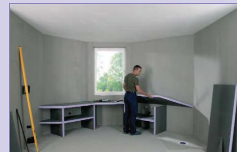
Le plan de toilette est collé sur les panneaux de soutien. Avant la pose du carrelage, il faut armer tous les joints de panneaux et les champs avec la bande d'armature JACKOBOARD.
