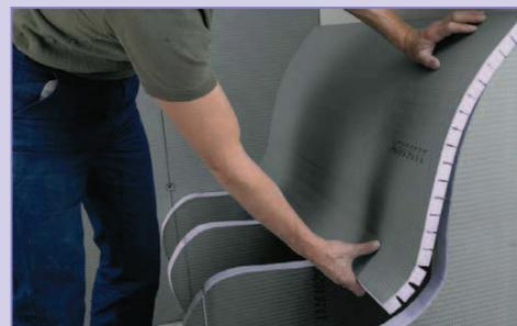
Le panneau créatif JACKOBOARD s'adapte parfaitement au support. Sur cette application, le panneau créatif est utilisé avec les strites au-dessous et celui-ci est collé avec la colle de montage JACKODUR. Pour effectuer un montage simple, des vis à bois peuvent être utilisées pour fixer ponctuellement le panneau créatif.
