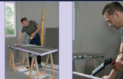
Les panneaux JACKOBOARD sont mesurés et découpés. La colle de montage JACKODUR est utilisée pour fixer les champs.
