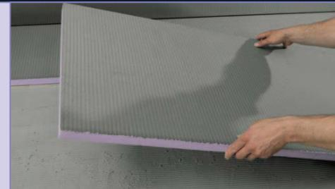
Au sol, afin de prévenir les fissures et en complément d'isolation thermique, les panneaux sont fixés avec une colle flexe.
