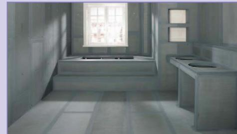
Terminer en recouvrant chaque liaison de panneaux avec la bande d'armature ou la bande d'étanchéité JACKOBOARD. La salle de bain peut être carrelée ou enduite.
