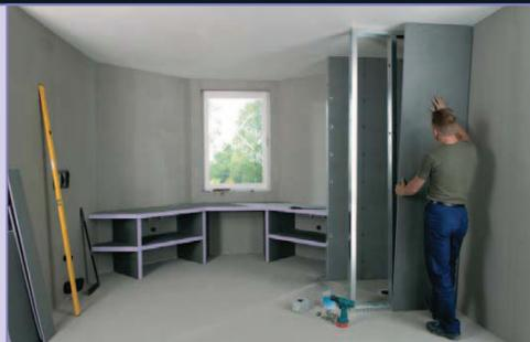
Le bac de douche JACKOBOARD est intégré à la chape. La structure métallique donne la base de montage pour les panneaux JACKOBOARD découpés aux dimensions.
