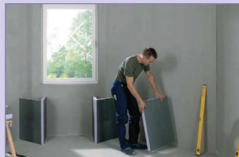
En soutien du plan de toilette, les panneaux JACKOBOARD sont collés au mur et au sol.
