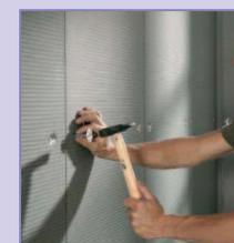
Après séchage du mortier, percer avec une perceuse à percussion à l'endroit des trous de marquage. Fixer ensuite à l'aide des chevilles en métal JACKOBOARD.
