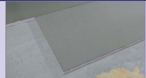
Les panneaux JACKOBOARD sont posés au sol de niveau.
