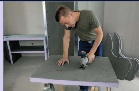
Le support de construction du banc est construit en panneau JACKOBOARD 5cm et coupé à la scie sauteuse.
