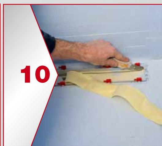
10 En cas d'utilisation d'une natte, couper soigneusement au cutter la partie couvrant l'intérieur du caniveau.
