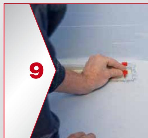
9 Choisir et positionner les cales de couleurs bleu/rouge pour ajuster la hauteur du cadre et de la grille à la hauteur du carrelage : 6 (sans cales), 8, 10, 12 et 16 mm.
