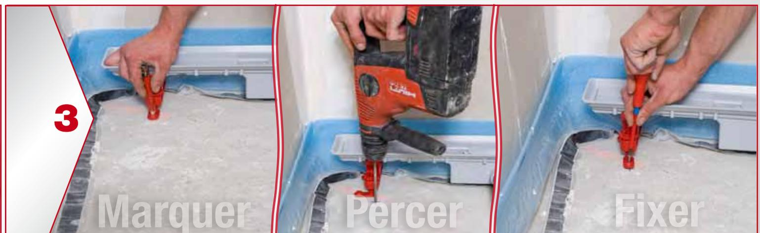
3 Positionner le caniveau à l'emplacement désiré. Marquer, percer et fixer le au sol.
