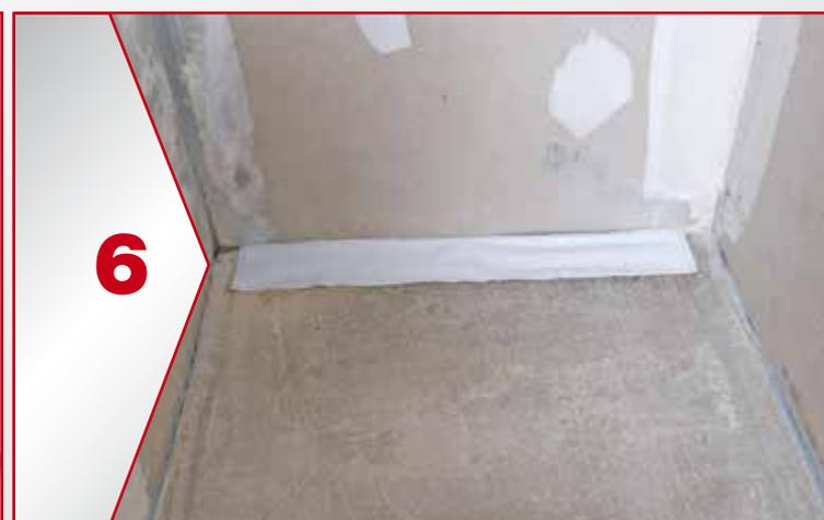
6 Coller l'autocollant de protection sur le caniveau puis réaliser la chape avec une pente de 1 à 2 cm/m
